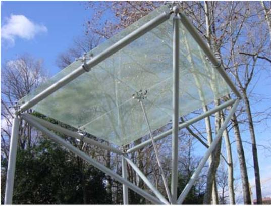
Fig.20. Prototipo de una de las células de las marquesinas de entrada de la Ciudad Financiera del BSCH equipada con fijaciones puntuales Gluepart™.
