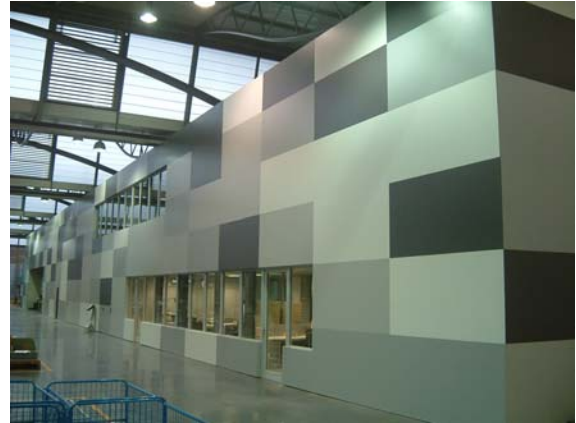
Fig.10. Vista de la fachada de oficinas dentro de la nave
