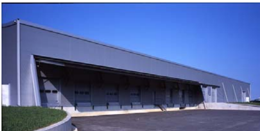
Fig 4. Detalle de la puerta-marquesina en muelles de carga
