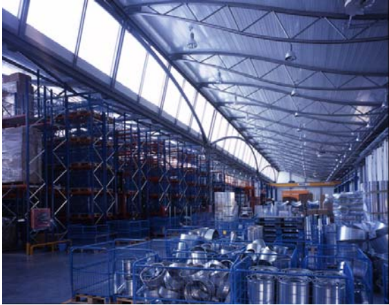
fig 2. Vista de un módulo en diente de sierra con los grandes lucernarios orientados al Norte
