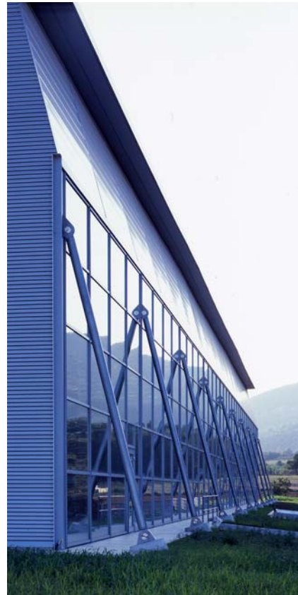
Fig 3. Detalle de la fachada Norte donde se aprecian los elementos de estabilidad longitudinal y el muro cortina transparente
