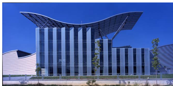
Fig 9. Vista de la fachada Este
