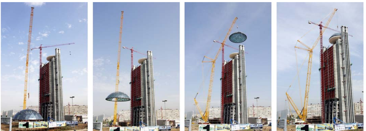
Fig. 4: The hoisting manoeuvre.
